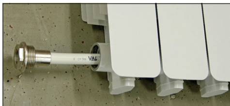
Рис.21 Установка удлинителя потока
